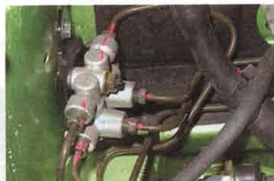
Расположение регулятора давления в моторном отсеке
