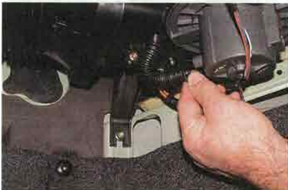
Отсоединяем шланг вентиляции от патрубка электродвигателя вентилятора. Отжав пластмассовую защелку...
